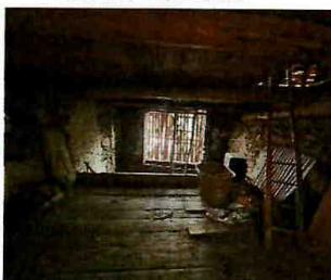
Interni del sottotetto ligneo
